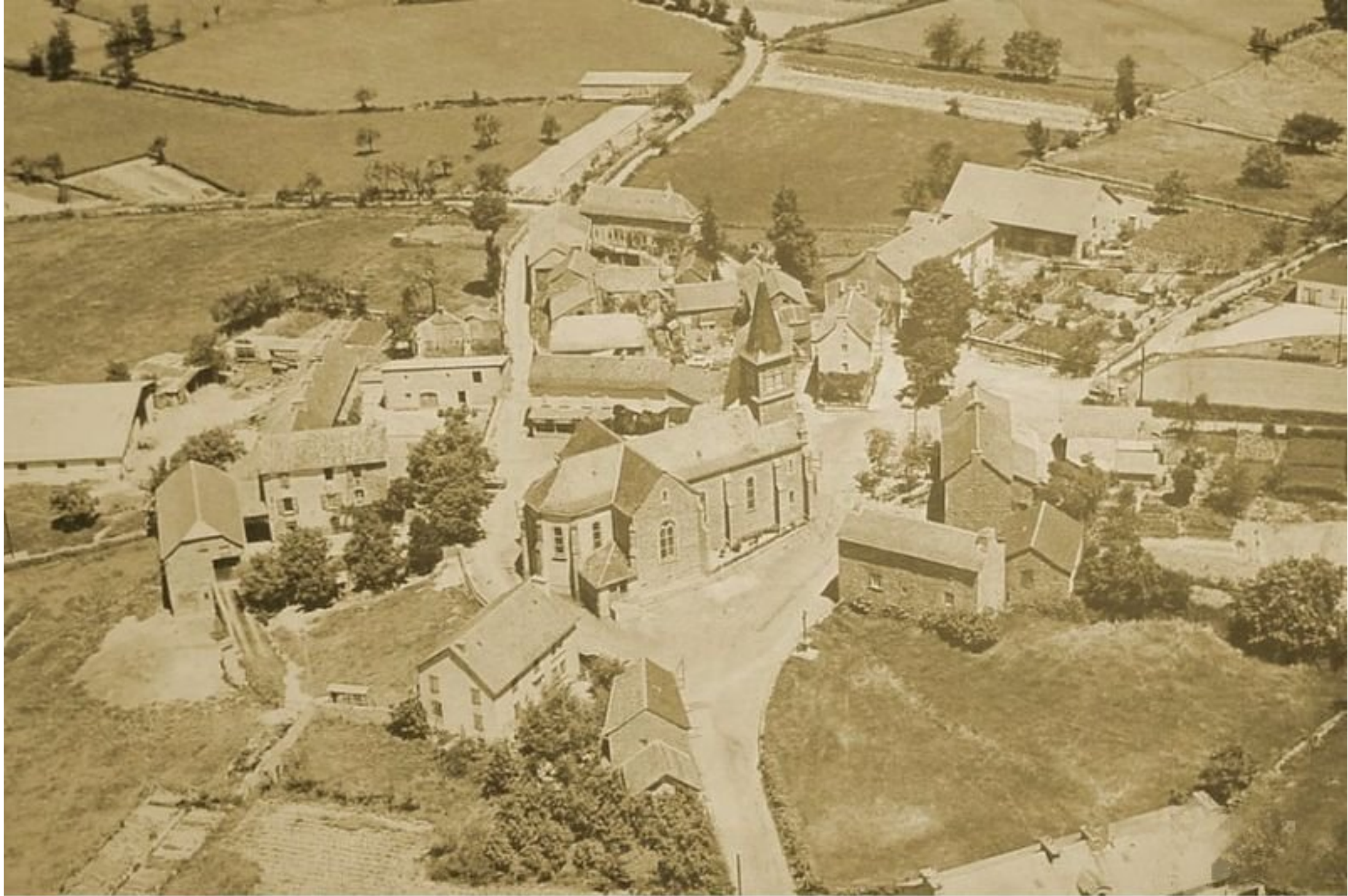
Meljac - le Bourg: arrivée du cimetière sur le bourg; en bas à gauche, l'ancien presbytère, à droite le toit de la mairie.
